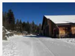
Le hangar à dameuse à Prénovel (sous la neige, l'enrobé...)
